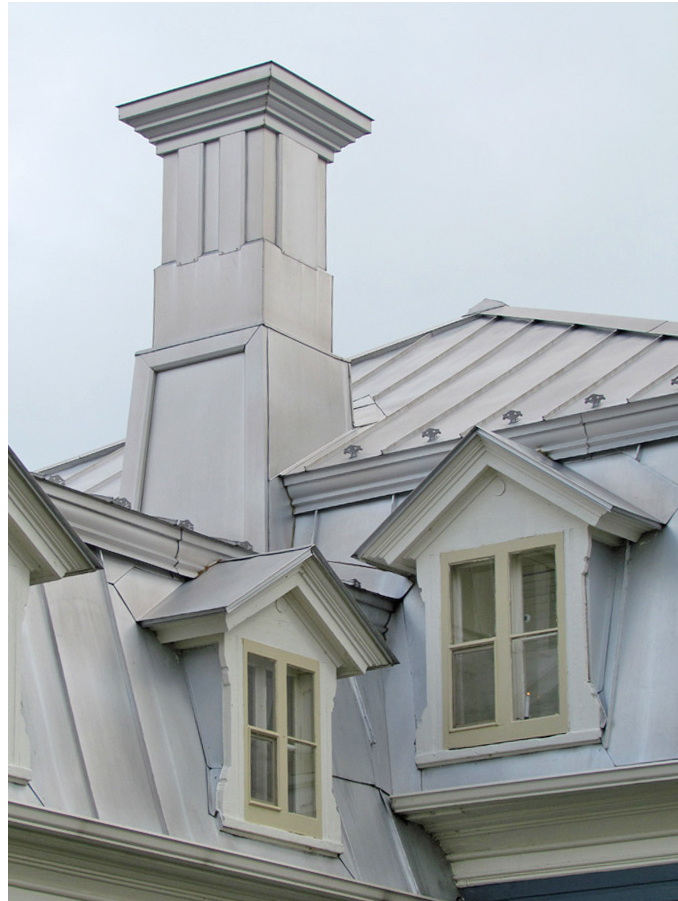
Cheminée recouverte de tôle moulurée. Maison Hubert-Messier au 386, chemin du Rivage, Saint-Antoine-sur-Richelieu. IMG_5245.jpg
