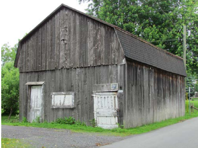
Petite grange d'intérêt historique puisqu'elle aurait été utilisée par la Compagnie des bâtons de clôture lors de la Rébellion de 1837. 251, rue du Lion, Saint-Denis-sur-Richelieu. IMG_2745.jpg
