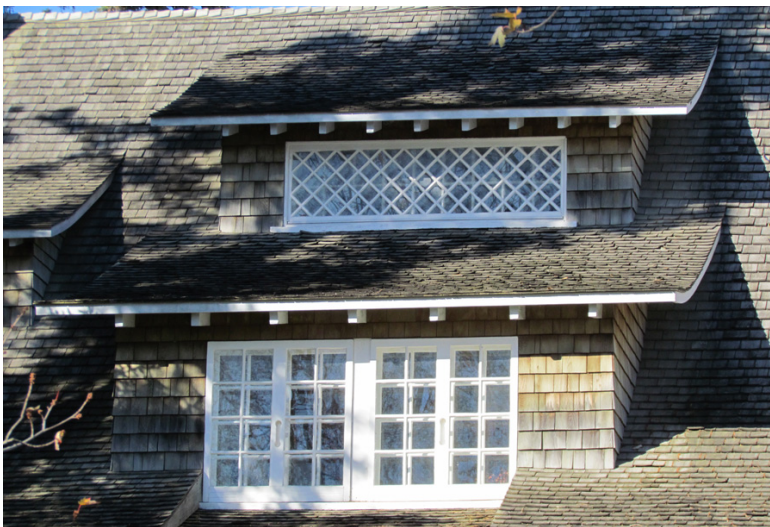
Lucarnes en appentis superposées d'un genre tout à fait exceptionnel. Maison Lecours au 380, rue Richelieu, Belœil. IMG_8986.jpg
