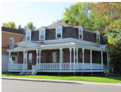
Exemple de maison à toit mansardé sur quatre côtés. Le 2044, avenue Bourgogne, Chambly. IMG_6783.jpg
