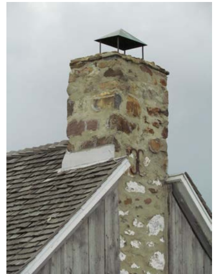
Souche d'une cheminée intégrée au mur. Maison Morissette au 209, chemin des Patriotes, Saint-Charles-sur-Richelieu. IMG_3914.jpg
