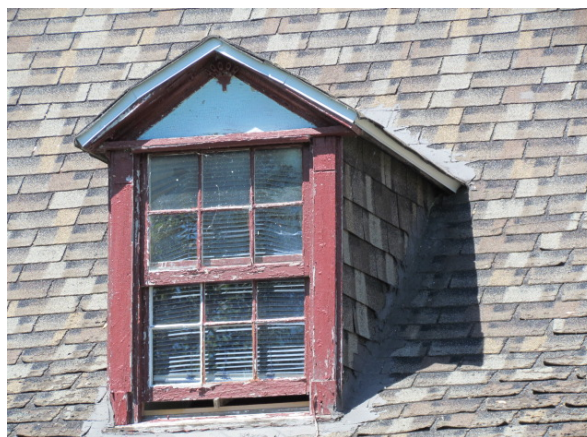
Lucarne à pignon, le modèle le plus courant. Maison Boileau au 22-24, rue Martel, Chambly. IMG_1493.jpg
