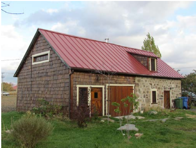
Ancien hangar à grains en pierre, datant des environs de 1815. 38, boulevard Yvon-L'Heureux Sud, Belœil. IMG_8824.jpg
