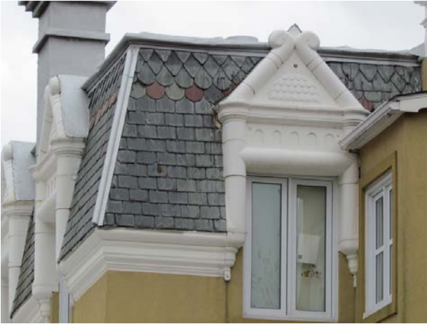
Exemple de revêtement d'ardoise au 100, chemin des Patriotes Nord, Mont-Saint-Hilaire. IMG_8321.jpg
