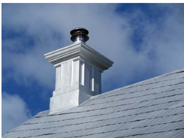
Revêtement de tôle à la canadienne au 970, chemin du Rivage, Saint-Antoine-sur-Richelieu. IMG_5570.jpg
