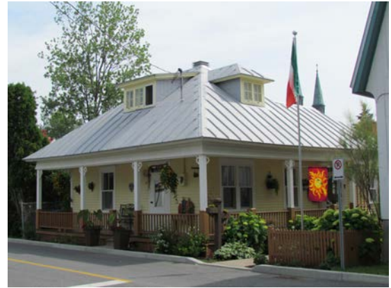
Exemple de bungalow ancien. Le 122, avenue Saint-Thomas, Saint-Denis-sur-Richelieu.
