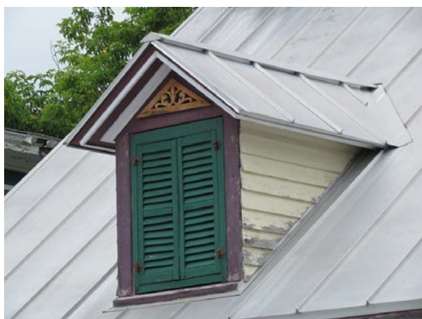
Tôle pincée au 149, avenue de Yamaska, Saint-Denis-sur-Richelieu. IMG_2851.jpg
