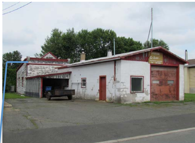
Ancien atelier de ferblanterie où Irénée Bélanger fabriquait, entre 1904 et 1949, ces magnifiques cheminées très ornées qui singularisent tant aujourd'hui le patrimoine bâti de la vallée du Richelieu. 133, rue Cartier, Saint-Denis-sur-Richelieu. IMG_2940.jpg
