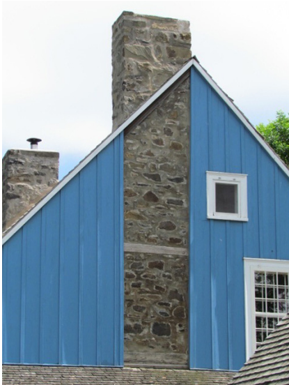
Cheminée intégrée au mur de maçonnerie. Maison Thomas-Whitehead au 2592, avenue Bourgogne, Chambly. IMG_1606.jpg
