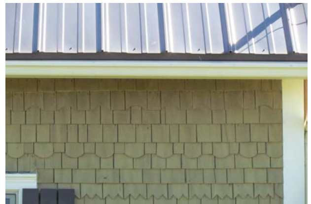
Exemple de revêtement de bardeau de bois découpé, un parement mural de plus en plus rare dans la MRC. 3125, rang des Soixante, Saint-Jean-Baptiste. IMG_6174.jpg
