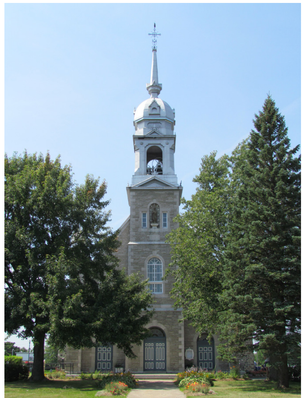
Église Saint-Marc, Saint-Marc-sur-Richelieu, second plus ancien temple catholique de la MRC, puisqu'elle date de 1801. Elle est la première église à être construite au Québec par l'abbé Pierre Coneyroy, architecte fort actif en architecture religieuse au Québec IMG_4634.jpg
