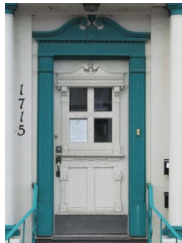
Porte à panneaux avec vitrage à grands carreaux, garnie de plusieurs appliques et d'un chambranle ornementé, au 1715, avenue Bourgogne, Chambly. IMG_1323.jpg
