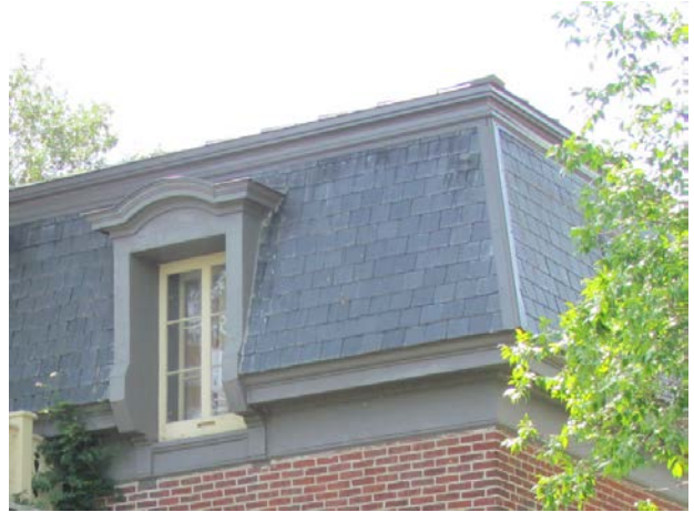
Revêtement d'ardoise sur le brisis du 593, rue Richelieu, Saint-Marc-sur-Richelieu. IMG_4649c.jpg
