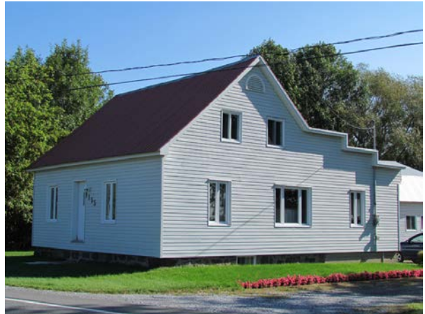
La modification importante de la volumétrie d'origine est observable à l'arrière du 1155, rang de la Rivière Sud, Saint-Jean-Baptiste, par un agrandissement intégré de façon inharmonieuse au corps principal. À cela s'ajoute le changement des revêtements et des ouvertures. IMG_6112.jpg
