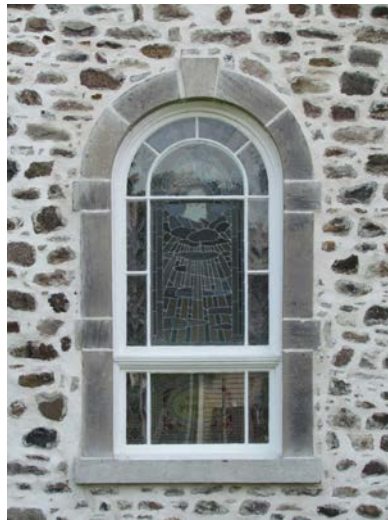
Chambranle et appui en pierre de fenêtre cintrée. Église Saint-Denis au 636, chemin des Patriotes, Saint-Denis-sur-Richelieu. IMG_2344.jpg
