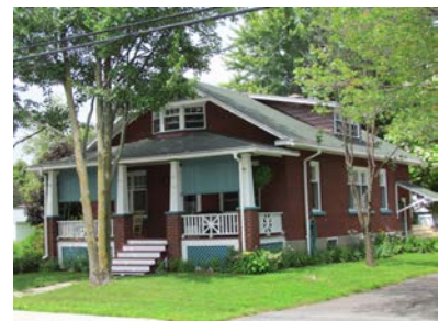
Exemple de bungalow ancien. Le 177, avenue de Yamaska, Saint-Denis-sur-Richelieu. IMG_2899.jpg
