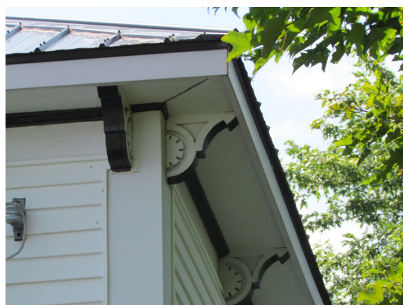
Consoles ouvragées au 272, 3 e Rang Sud, Saint-Charles-sur-Richelieu. IMG_4570.jpg
