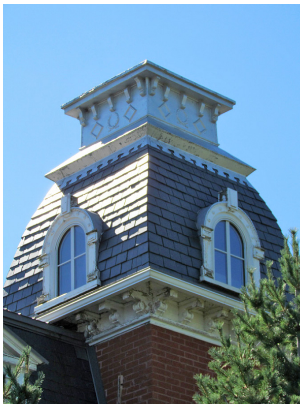
Tourelle ornementée d'une terrasse faitière, de lucarnes cintrées et d'une corniche à consoles. Maison Taupier au 1622, avenue Bourgogne, Chambly. IMG_6595.jpg
