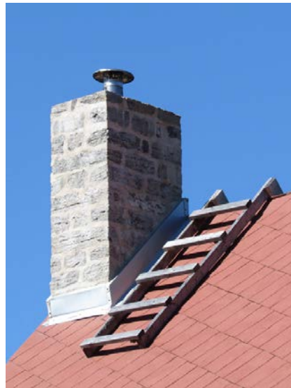
Souche de cheminée en pierre. Maison Henri-Bisaillon au 4976, chemin Salaberry, Carignan. IMG_6505.jpg
