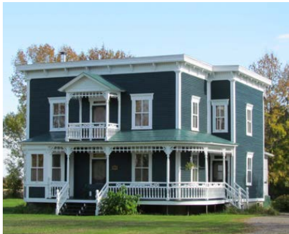
Un bâtiment principal au 987, rang de l'Acadie, Saint-Antoine-sur-Richelieu. IMG_6948.jpg
