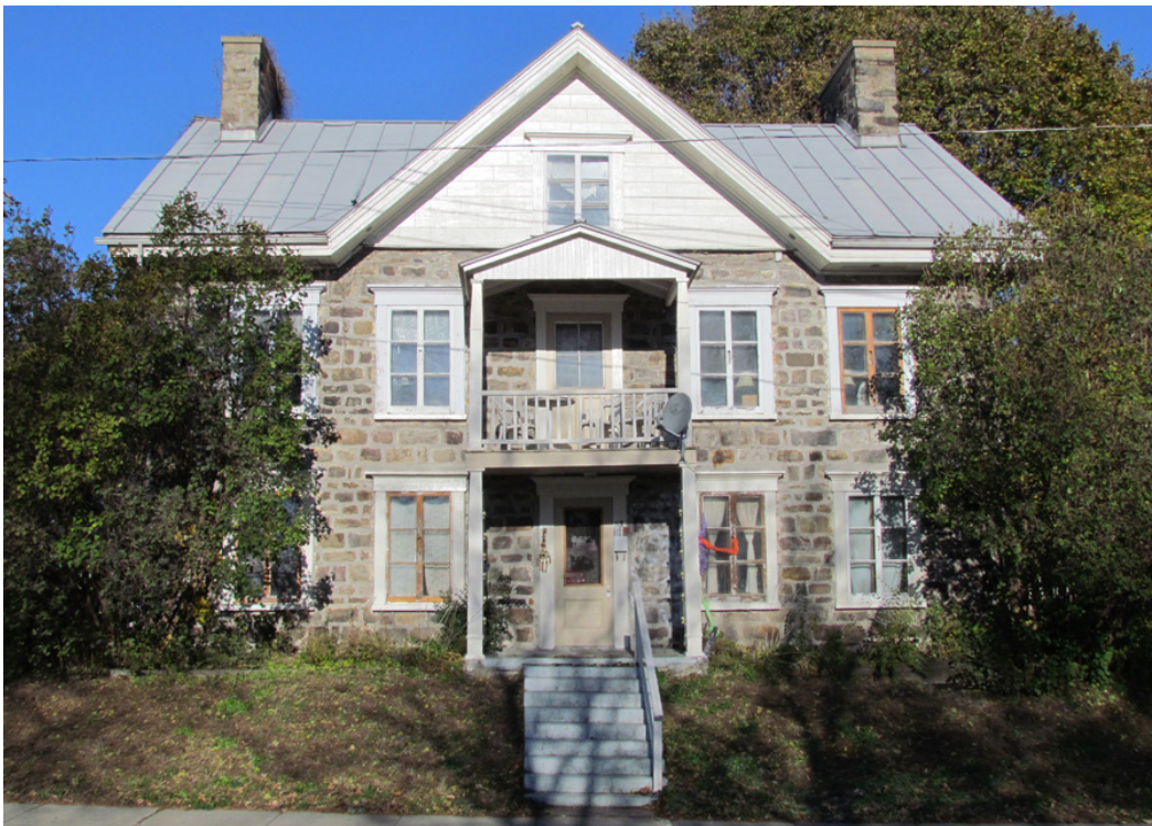
Maison Jean-Baptiste-Lamothe (ou maison Guertin), 96-98, rue Richelieu, Belœil, un immeuble patrimonial classé. IMG_8895.jpg
