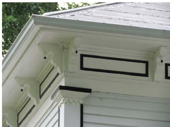
Chapiteau de planche cornière et corniche à consoles au 103, rang des Trente, Saint-Marc-sur-Richelieu. IMG_5046.jpg
