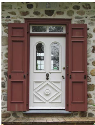
Porte à panneaux avec vitrage en arc plein cintre et imposte, encadrée de volets tout à fait exceptionnels au 957, chemin des Patriotes, Saint-Denis-sur-Richelieu. IMG_2491.jpg
