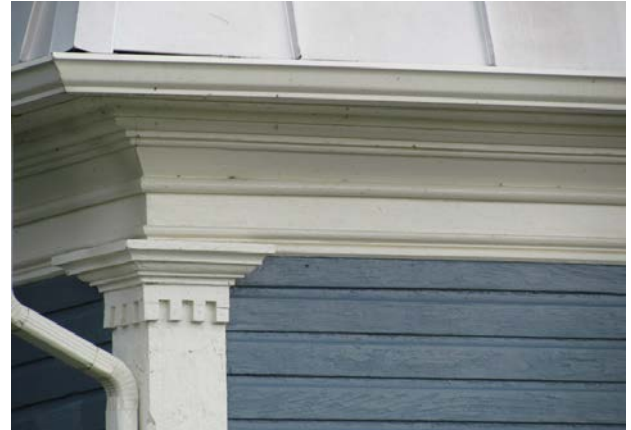
Revêtement de planche à feuillure au 386, chemin du Rivage, Saint-Antoine-sur-Richelieu. IMG_5244.jpg
