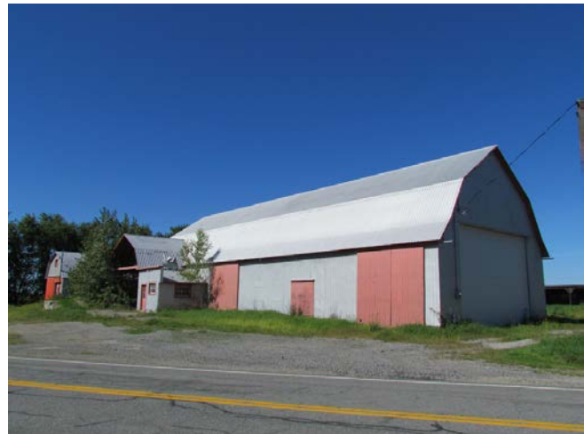
Une grange-étable au toit à deux versants dit brisés ou à deux sections, à la manière de la maison mansardée. 1794, chemin du Rivage, Saint-Antoine-sur-Richelieu. IMG_5960.jpg
