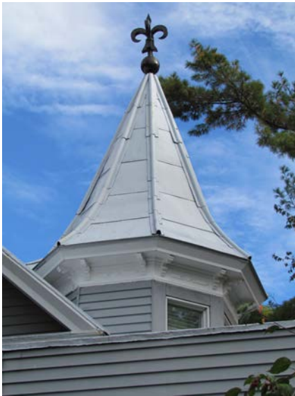
Tourelle surmontée d'un épi découpé au 1175, chemin de la Montagne, Mont-Saint-Hilaire. IMG_7642.jpg
