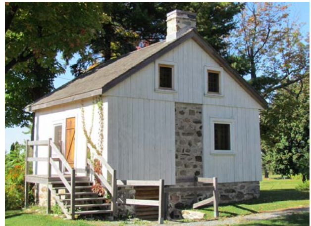
Exemple de maison de colonisation. Le 284, chemin Ozias-Leduc, Mont-Saint-Hilaire. IMG_7881.jpg
