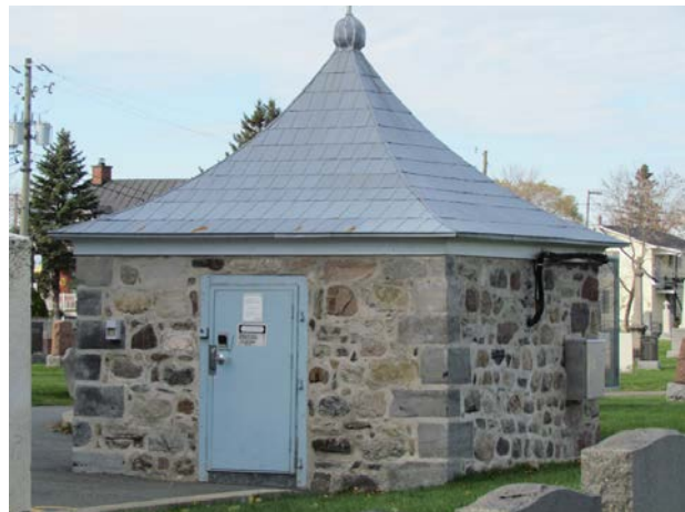
Construit en 1856, ce charnier en pierre singularise le cimetière de la paroisse Saint-Matthieu avec son toit pyramidal. 1020, rue Richelieu, Belœil. IMG_9477.jpg
