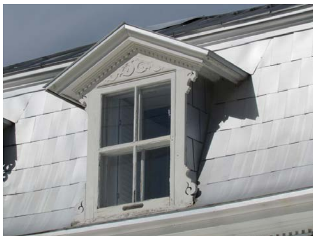
Tôle en plaques sur le brisis du 1087, chemin de la Montagne, Mont-Saint-Hilaire. IMG_7758.jpg
