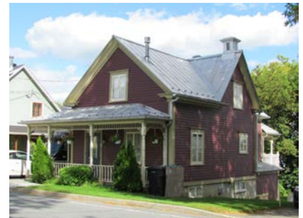
Exemple de maison de type vernaculaire américain (sous-type 1 à un niveau et demi), orientée «à pignon sur rue». Le 1061, rue du Rivage, Saint-Antoine-sur-Richelieu. IMG_5843.jpg
