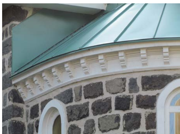
Corniche à consoles. Ancien couvent de Saint-Hilaire au 260, rue Saint-Hippolyte, Mont-Saint-Hilaire. Img_8638.jpg
