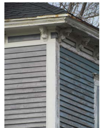
Jonction d'une planche cornière simple et d'une corniche à consoles au 894, rue Richelieu, Belœil. IMG_9260.jpg
