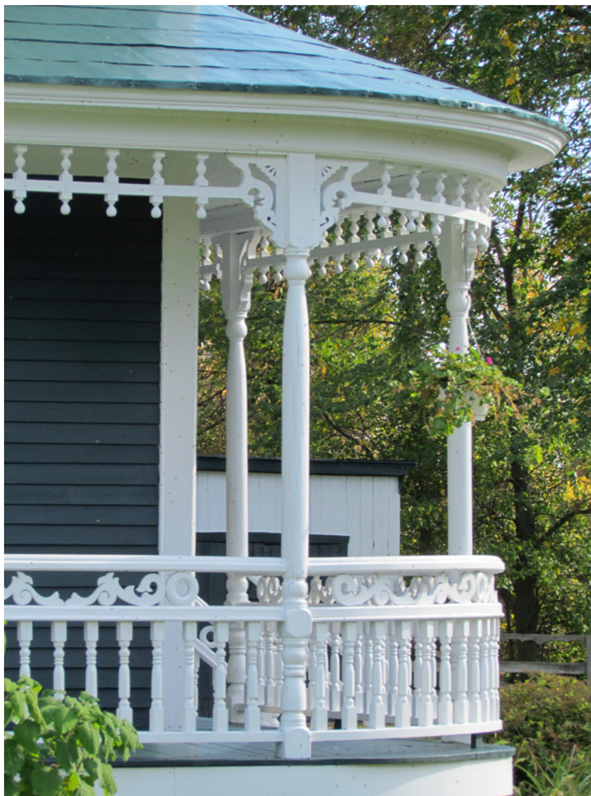
Garde-corps à balustres et à main-courante découpée, surmonté d'un lambrequin et d'aisseillers au 987, rang de l'Acadie, Saint-Antoine-sur-Richelieu. IMG_6958.jpg
