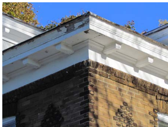
Corniche à consoles au 76, rue Richelieu, Belœil. IMG_8876.jpg
