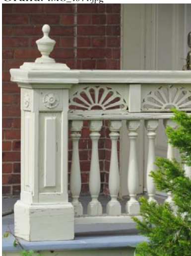
Poteau d'arrêt et garde-corps avec balustres et main-courante découpée. Maison Beattie au 12, rue De Richelieu, Chambly. IMG_1716.jpg
