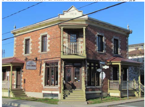
Un édifice à fonction mixte au 101-103, rue Saint-Jean-Baptiste, Belœil. IMG_9631.jpg
