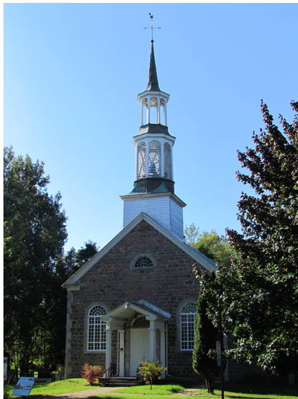
Église anglicane Saint-Stephen, construite en 1820, sur le terrain de la base militaire britannique de Chambly. 2004, avenue Bourgogne, Chambly. IMG_6751.jpg
