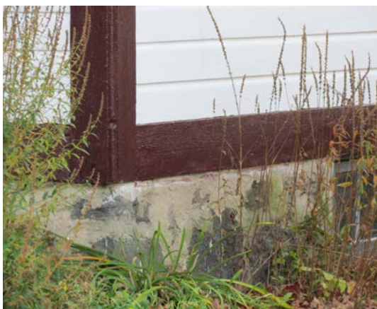
Planche cornière effectuant la jonction entre la fondation et le revêtement de façade au 66-68, rue Saint-Henri, Mont-Saint-Hilaire. IMG_8625.jpg
