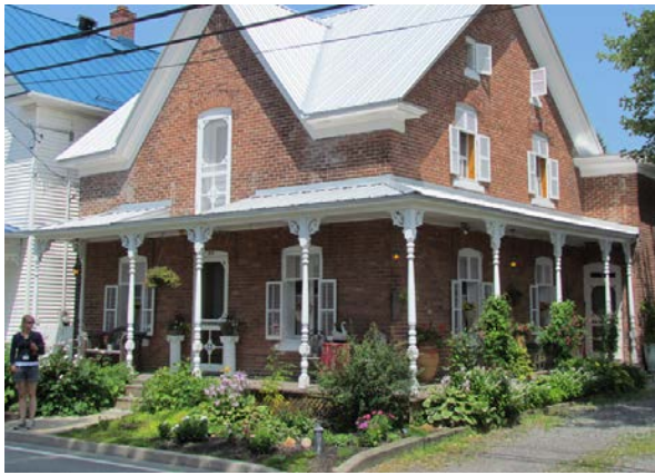
Galerie ornementée de colonnes tournées et d'aisseillers au 20, rue de l'Union, Saint-Charles-sur-Richelieu. IMG_4597.jpg
