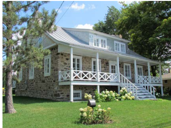
Exemple de maison traditionnelle québécoise. La Maison Louis-Chicou-Duvert, 438 chemin des Patriotes, Saint-Charles-sur-Richelieu. IMG_4227.jpg
