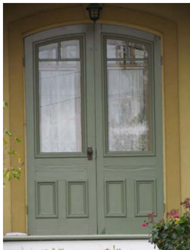
Porte en arc surbaissé à doubles battants, avec panneaux et vitrage, au 100, chemin des Patriotes Nord, Mont-Saint-Hilaire. IMG_8320.jpg
