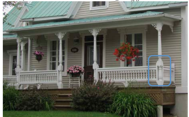
Garde-corps où on a l'impression qu'un balustre est encasté dans les colonnes au 680, chemin des Patriotes, Saint-Denis-sur-Richelieu. IMG_2444.jpg
