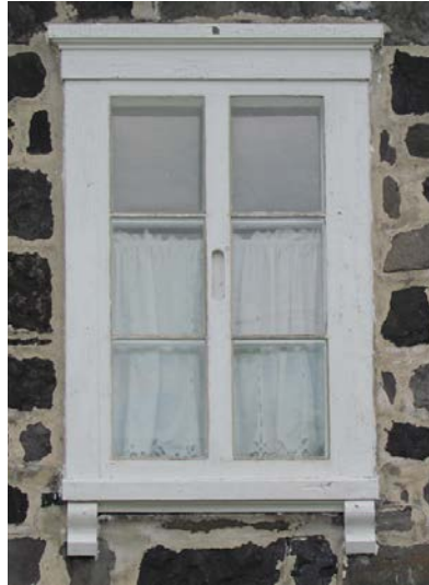
La fenêtre à battants à six grands carreaux, la plus fréquente sur les bâtiments inventoriés, toutes périodes confondues. Maison Monast-Lahaise au 411, chemin des Moulins, Mont-Saint-Hilaire. IMG_7691.jpg
