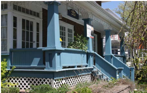
Galerie avec garde-corps plein et colonnes à socle au 225, rue Principale, Saint-Basile-le-Grand. IMG_4574.jpg
