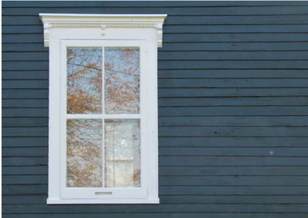
Le plus courant des revêtements de bois : la planche à clin au 917, rang de l'Acadie, Saint-Antoine-sur-Richelieu. IMG_6953.jpg
