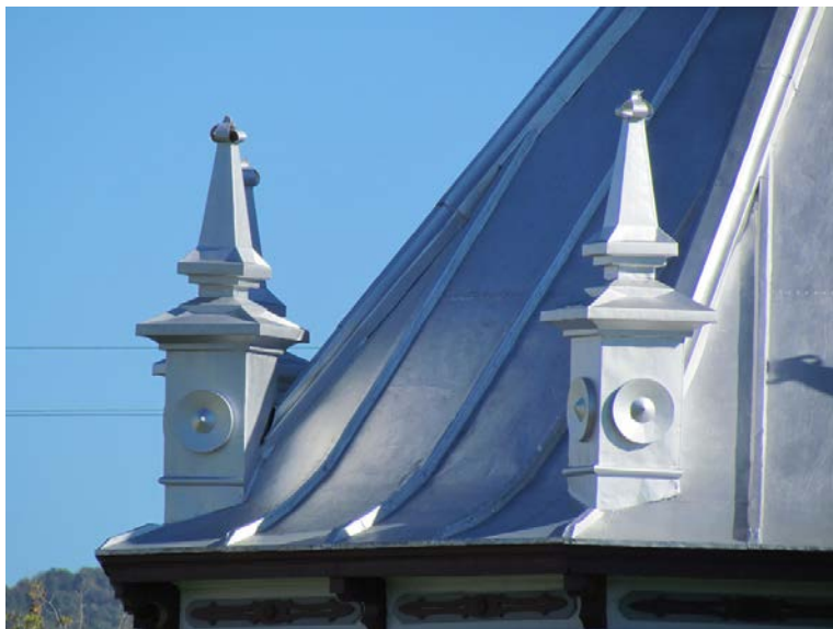
Petits amortissements en tôle moulurée. Chapelle du cimetière de la paroisse Saint-Jean-Baptiste au 3097, rue Principale, Saint-Jean-Baptiste. IMG_6323.jpg
