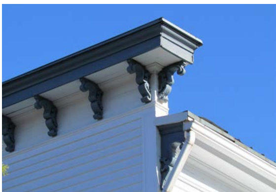
Mur parapet agrémenté d'une corniche à consoles au 106, rue Choquette, Belœil. IMG_9135.jpg
