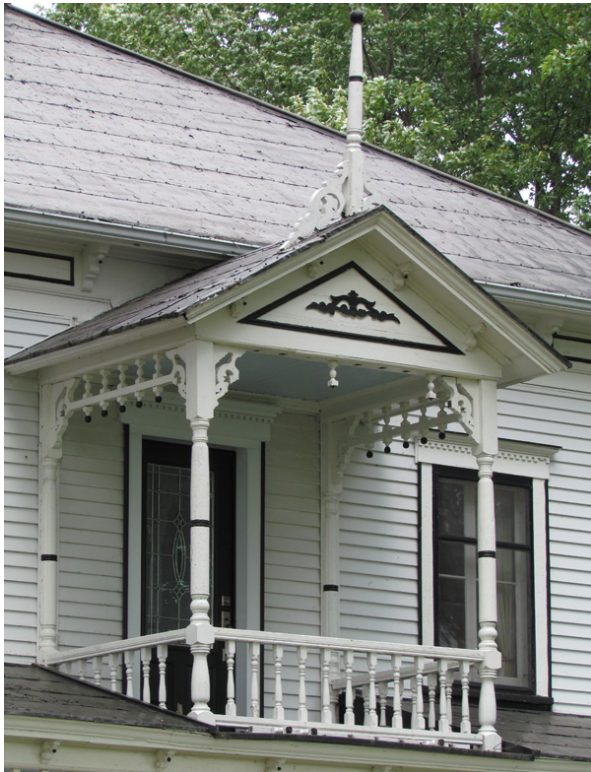
Balcon ornementé d'une balustrade et de colonnes tournées avec aisseliers et lambrequin, surmonté d'un fronton avec appliques découpées et d'un épi au 103, rang des Trente, Saint-Marc-sur-Richelieu. IMG_5031.jpg
