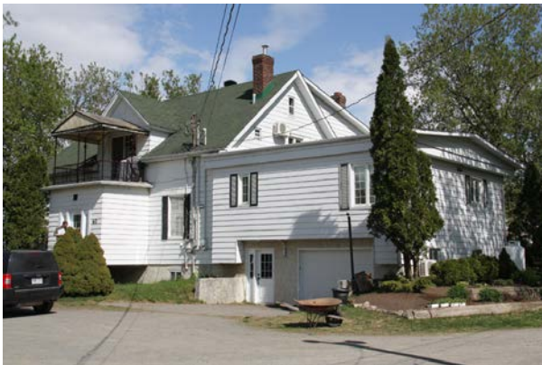
Ancienne école du rang des Vingt-Quatre au 40, rue Principale, Saint-Basile-le-Grand. Le volume d'origine demeure difficilement perceptible.
