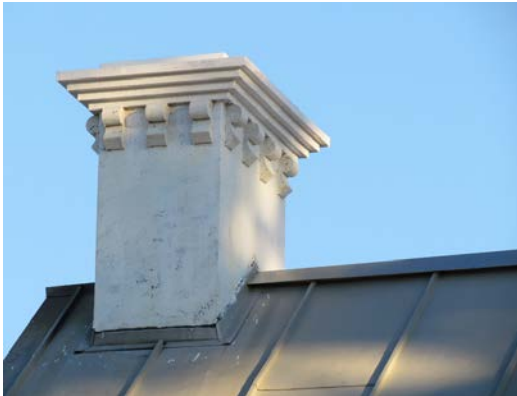
Cheminée ornementée de consoles. 390, chemin des Patriotes Nord, Mont-Saint-Hilaire. IMG_8138.jpg
