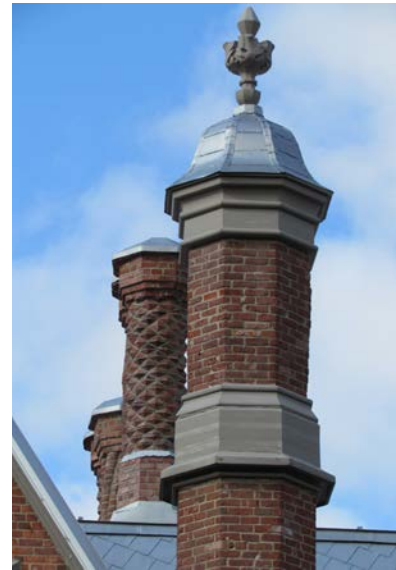
Amortissements en briques. Manoir Rouville-Campbell au 125, chemin des Patriotes Sud, Mont-Saint-Hilaire. IMG_8344.jpg
