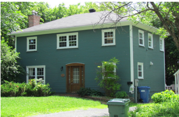
Les ouvertures, les revêtements et les composantes décoratives ont été modifiés au 2608, avenue Bourgogne, Chambly. IMG_1569.jpg
