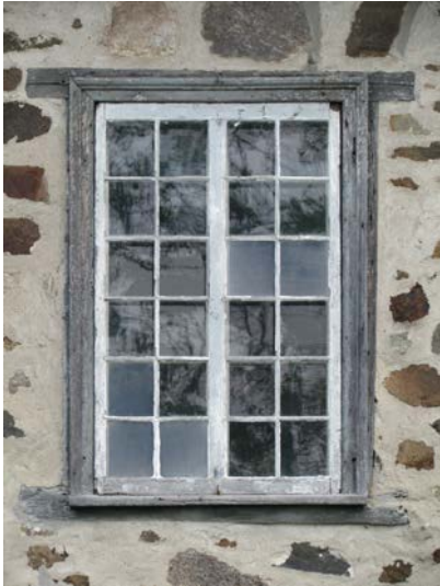
La maison Louis-Degneau au 1523, chemin de Chambly, à Carignan, possède un modèle de fenêtres à battants à 24 petits carreaux, typique du 18 e siècle. IMG_3407.jpg
