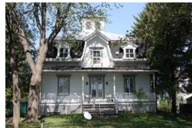
Exemple de maison de style Second Empire. Maison Chagnon, 165, rue Principale, Saint-Basile-le-Grand. BIMG_4499.jpg
