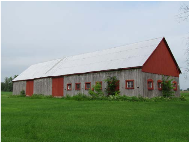
Une grange-étable au toit à deux versants droits, très bien préservée, revêtue de planche unie. 334, chemin des Patriotes, Saint-Denis-sur-Richelieu. IMG_2605.jpg
