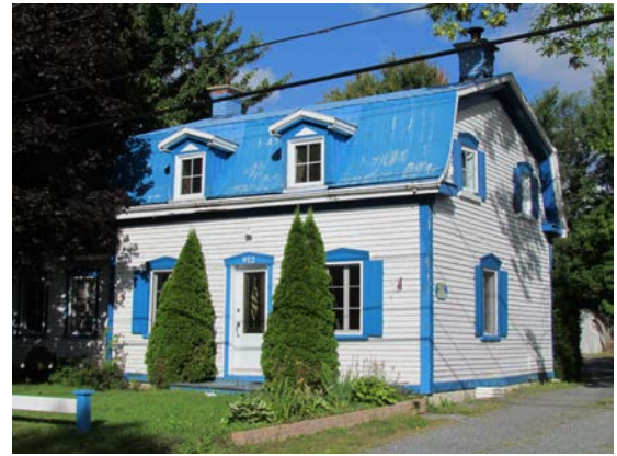
Exemple d'édifice à toit mansardé. Le 912, rue du Rivage, Saint-Antoine-sur-Richelieu. IMG_5501.jpg
