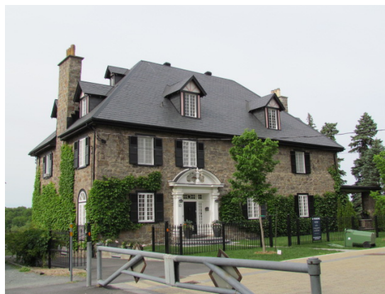
Exemple d'un édifice « hors type », le seul édifice en son genre dans la MRC, la maison Ducharme au 10, rue De Richelieu, Chambly.
