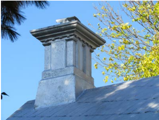
Ce type de cheminée est vraiment typique de la région de la vallée du Richelieu. Maison Bélanger au 312, rang de l'Acadie, Saint-Antoine-sur-Richelieu. IMG_7580.jpg
