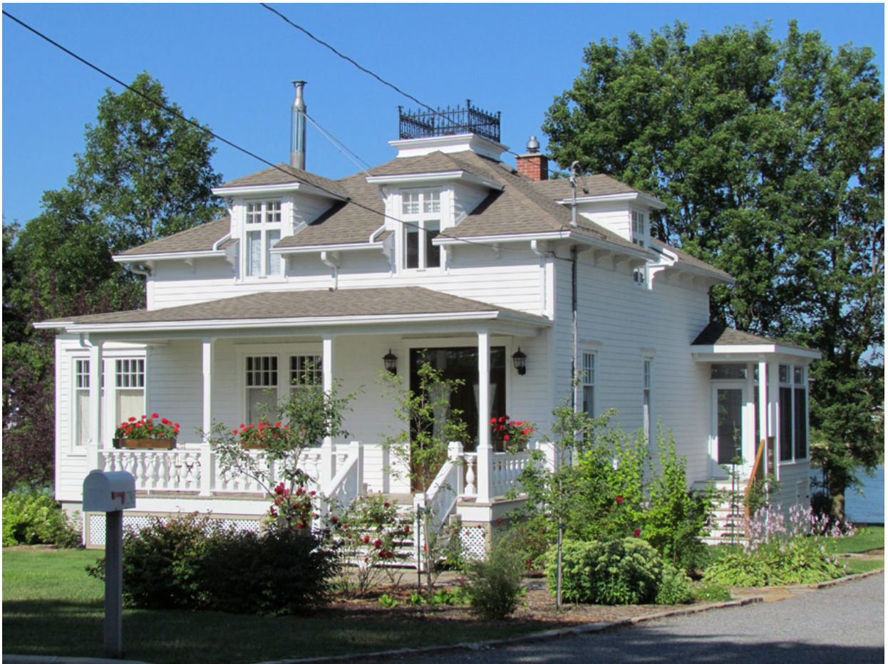
Le 395, chemin des Patriotes, Saint-Charles-sur-Richelieu, un immeuble construit vers 1930 présentant une excellente d'authenticité. IMG_3955.jpg
