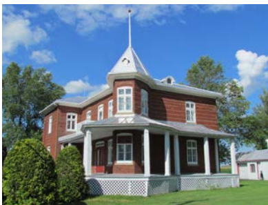
Exemple de maison de style Queen Anne. Le 290, chemin des Patriotes, Saint-Charles-sur-Richelieu. IMG_4350.jpg
