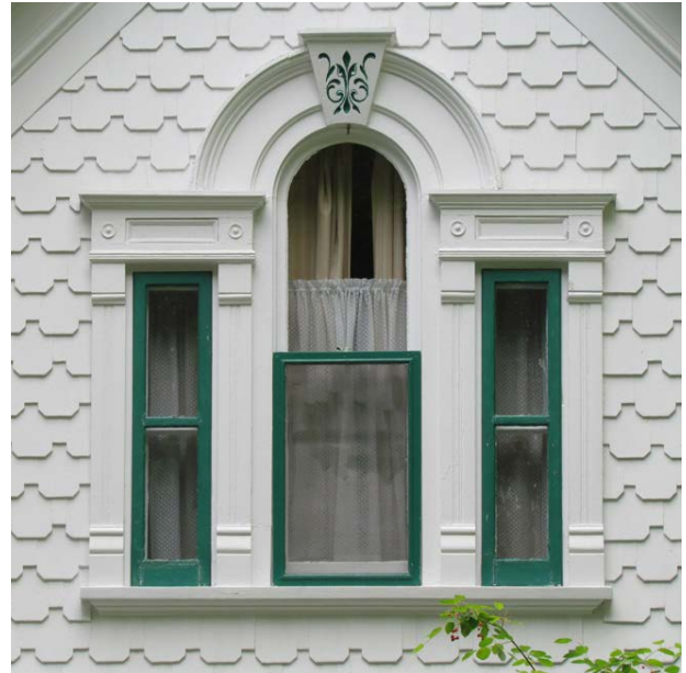
Chambranle ouvragé de fenêtre serlienne. Maison du docteur Jean-Baptiste-Richard au 611, chemin des Patriotes, Saint-Denis-sur-Richelieu. IMG_2262.jpg
