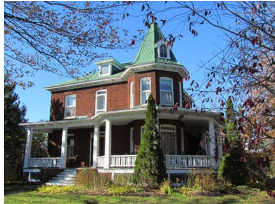
Exemple d'édifice de style Queen Anne. Le 790, rue Richelieu, Belœil. IMG_9108.jpg
