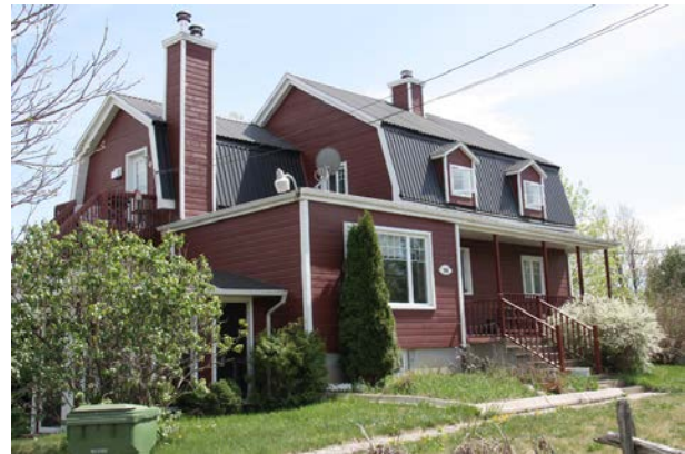
Le 68, rue Principale, Saint-Basile-le-Grand, agrandi de manière inadéquate par l'ajout d'un corps secondaire à l'avant. BIMG_4968.jpg
