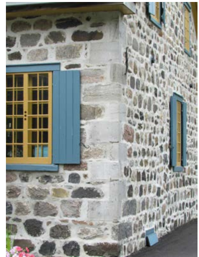
Chaîne d'angle en pierre au 2656, chemin Bellerive, Carignan. IMG_3270.jpg
