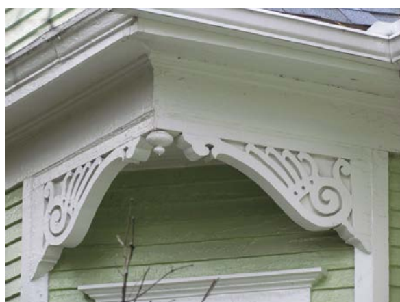
Consoles ouvragées et petite toupie pendante. Maison Hubert au 10-12, rue Hubert, Belœil. IMG_9238.jpg
