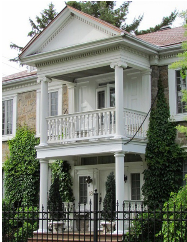
Galerie et balcon superposés, surmontés d'un fronton et d'une corniche d'inspiration classique et agrémentés d'une balustrade et de colonnes doriques au rez-de-chaussée et ioniques à l'étage. Manoir de Charles-Michel d'Irumberry de Salaberry au 18, rue De Richelieu, Chambly. IMG_1689.jpg
