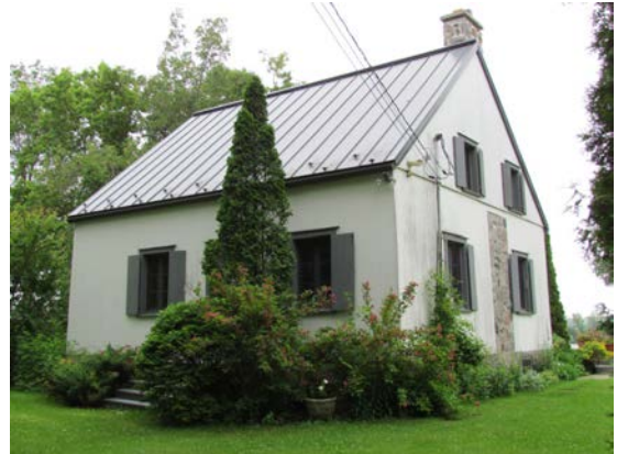
Exemple de maison de colonisation. Le 1149, chemin des Patriotes, Saint-Denis-sur-Richelieu. IMG_2517.jpg
