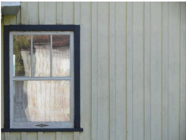
Détail d'un revêtement de planches à couvre-joints, le plus rare des parements de bois dans la MRC. 1821, chemin du Rivage, Saint-Antoine-sur-Richelieu. IMG_7314.jpg
