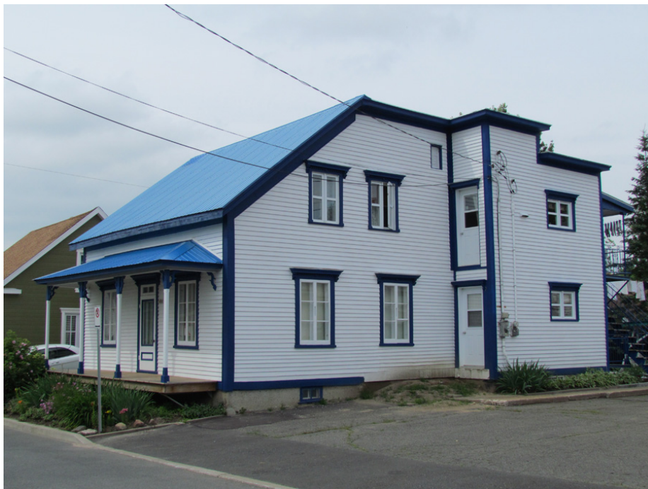
Au 133, avenue Cartier à Saint-Denis-sur-Richelieu, des modifications apportées au volume de l'édifice à l'arrière rendent difficilement perceptible sa volumétrie d'origine. IMG_2933.jpg
