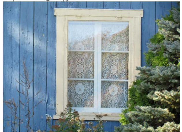
Exemple de revêtement de planche unie, que l'on retrouve ici sur une maison construite vers 1834. 628, rang du Brûlé, Saint-Antoine-sur-Richelieu. IMG_7548.jpg
