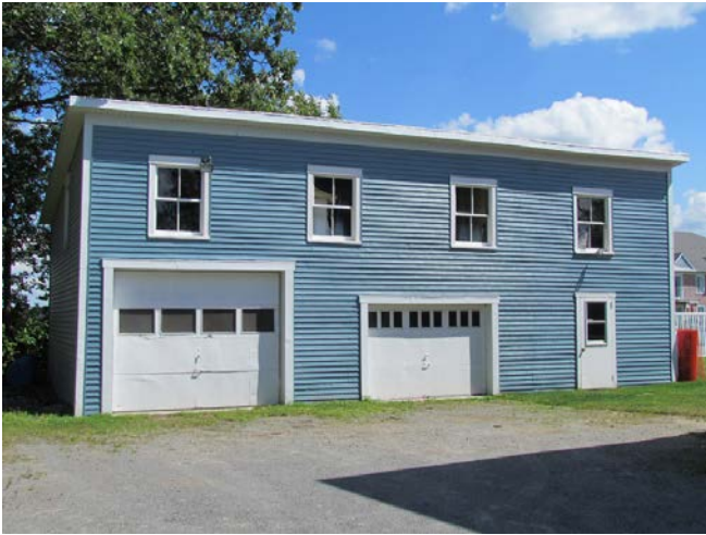
Bâtiment secondaire à toit plat (à pente faible unique). 430, chemin des Patriotes, Saint-Charles-sur-Richelieu. IMG_4238.jpg
