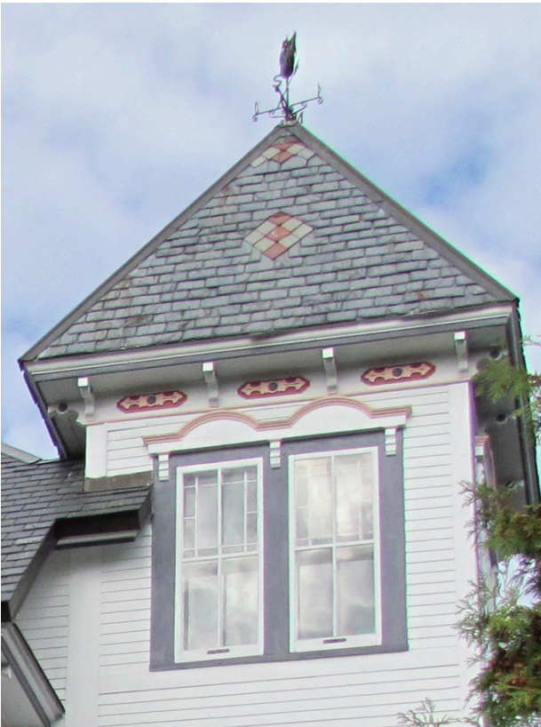
Revêtement d'ardoise au 1172, chemin de la Montagne, Mont-Saint-Hilaire. IMG_7659c.jpg
