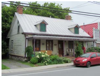
Exemple de maison à toit à deux versants droits d'influence néoclassique. Le 149, avenue de Yamaska, Saint-Denis-sur-Richelieu. IMG_2844.jpg
