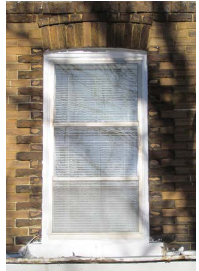
Fenêtre à guillotine où la contre-fenêtre s'ouvre vers l'extérieur, typique des édifices du début du 20 e siècle au 76, rue Richelieu, Belœil. IMG_8874.jpg
