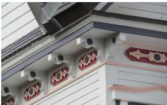
Corniche à consoles et motifs découpés au 1172, chemin de la Montagne, Mont-Saint-Hilaire. IMG_7650.jpg
